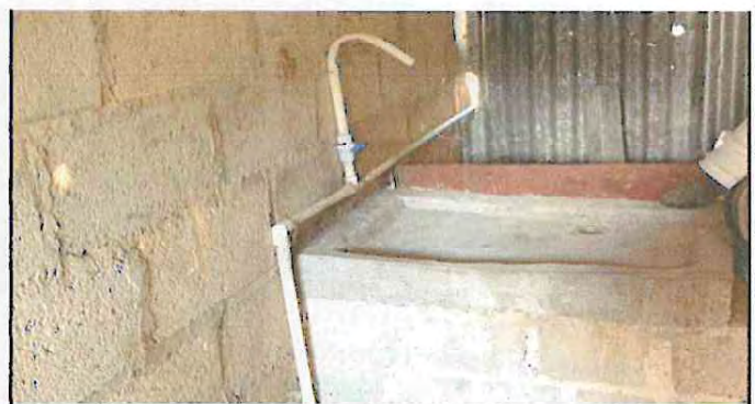
Foto 6: El lavatrastos esta de cemento. no se cuenta con mezclador. Solo con un tuvo para que llegue el agua.
