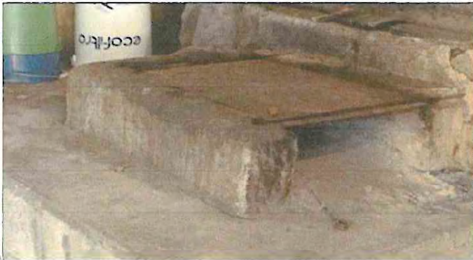
Foto 1: se encuentra la plancha de metal condeterioro por la antigüedad y su uso.
